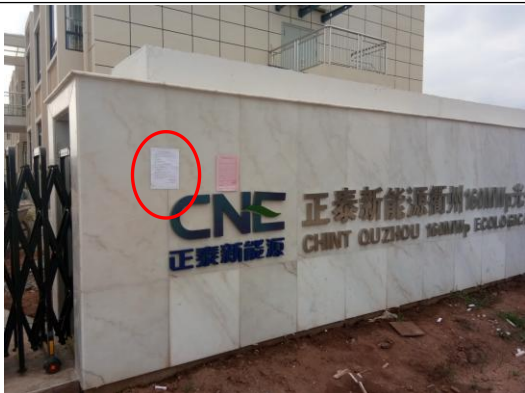
图 8-1 张贴在升压站门口的公示
