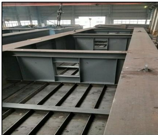
图 10-1 高架桥现场探伤图
