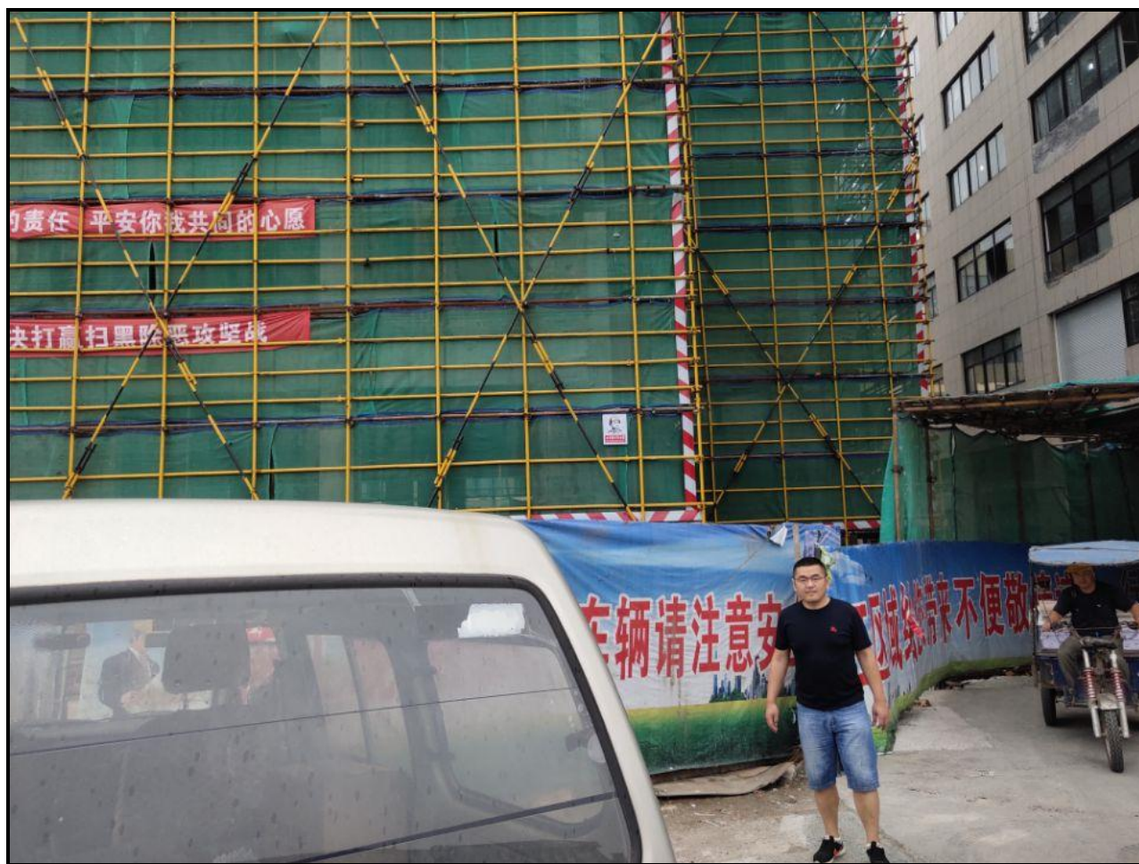
附图 6 现场踏勘照片
