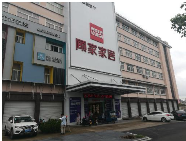
恒源工贸大楼 安仙安居钢管杆段南侧 20m
