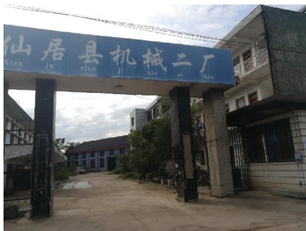
仙居机械二场 仙居~梅园线南侧 10m
