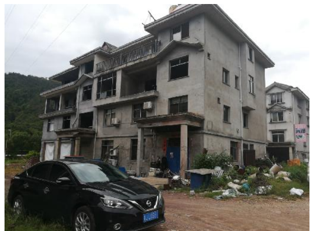
东岭下村安置一期郭姓民居 仙居~梅园线两侧 5m
