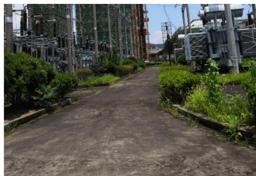
110kV 仙居变电站站内绿化及地面硬化
