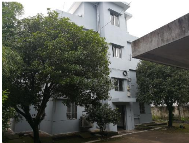
台州供电公司家属楼 变电站南侧 10~15m
