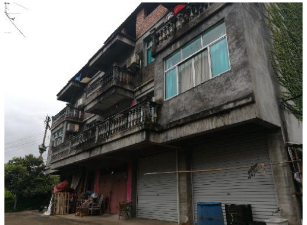
茶园路 27 号 变电站南侧隔墙
