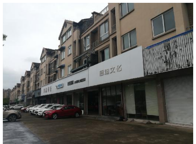
西灿村和家园小区东民居房 仙居~梅园线西侧 12m
