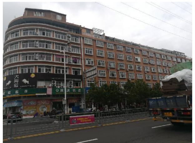
环城北路 475 号公寓 钢管杆段南侧 15m
