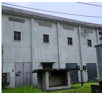
110kV 仙居变电站主控室
