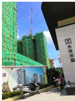
天台变东南侧在建居民楼
