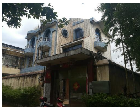
溪岸东路 223 号 清天线西侧 28m
