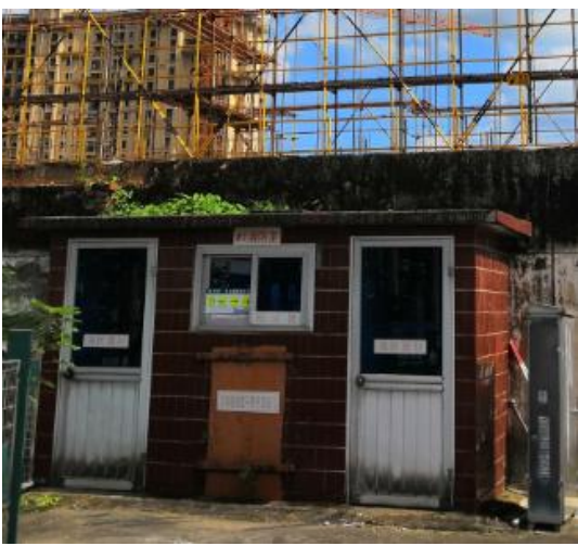
110kV 天台变电站主变消防室
