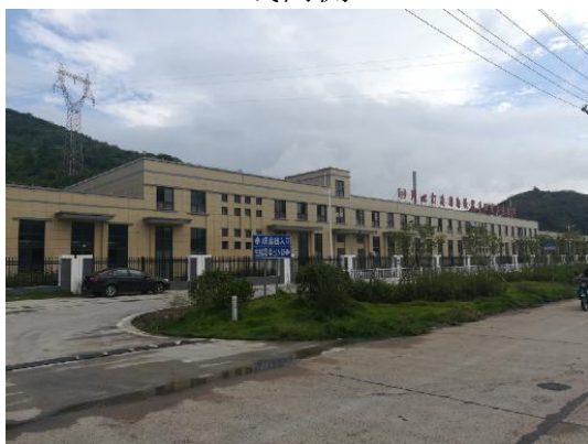
华统食品屠宰车间 临天线下
