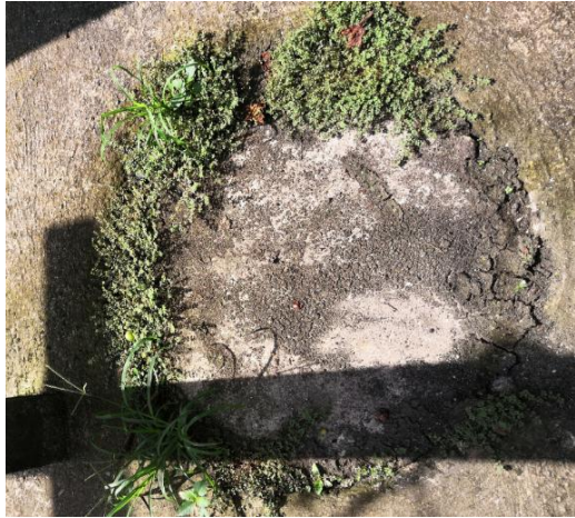
110kV 天台变电站污水处理设施
