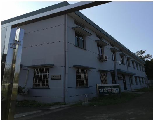
110kV 湖海塘变电站主控楼
