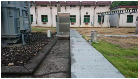
110kV 高塘变电站事故油池
