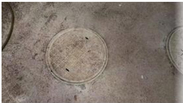
110kV 高塘变电站污水处理设施
