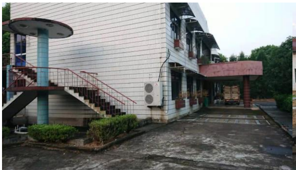
110kV 高塘变电站主控楼
