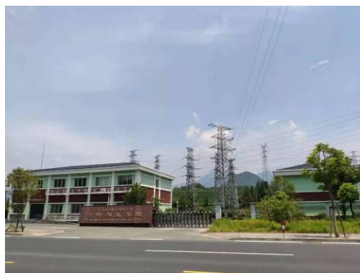
遂昌县供排水有限公司云峰加压泵站
