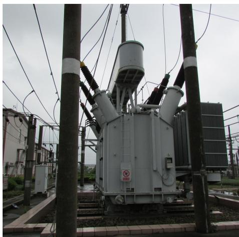
图 6-1 南湖变主变及下方油坑
