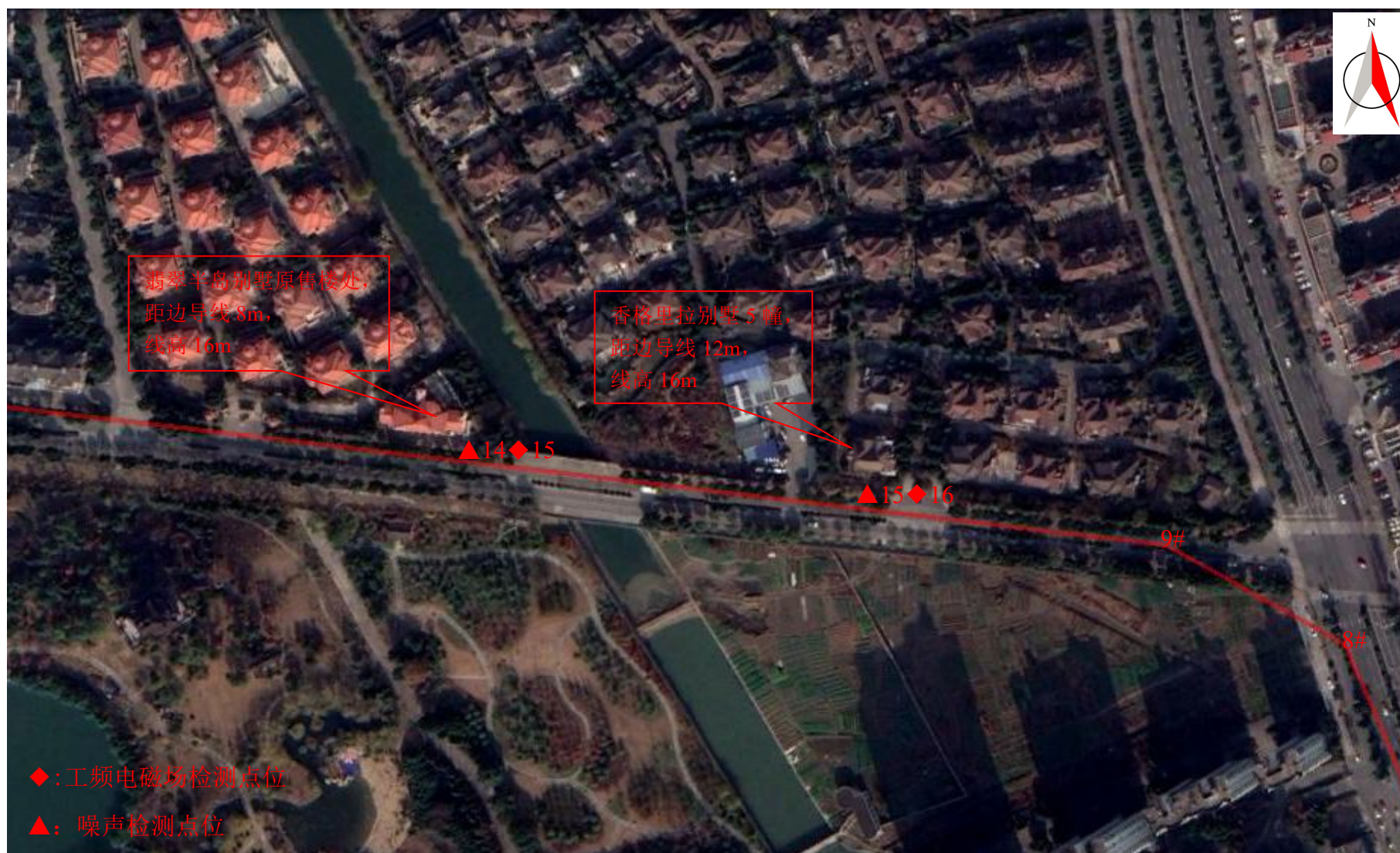
图 7-5 (5) 现场监测点位图 (110kV 北港输变电工程)
