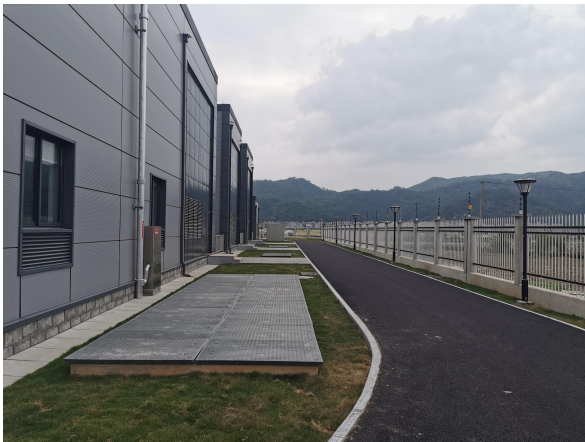
图 6-9 变电站内道路及绿化
