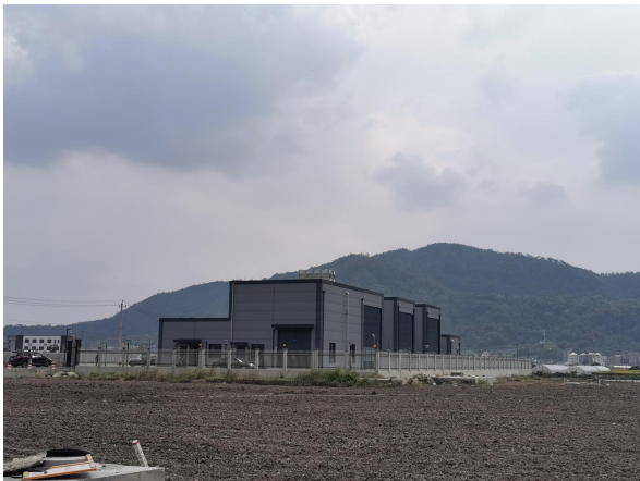
图 6-10 变电站整体环境现状
