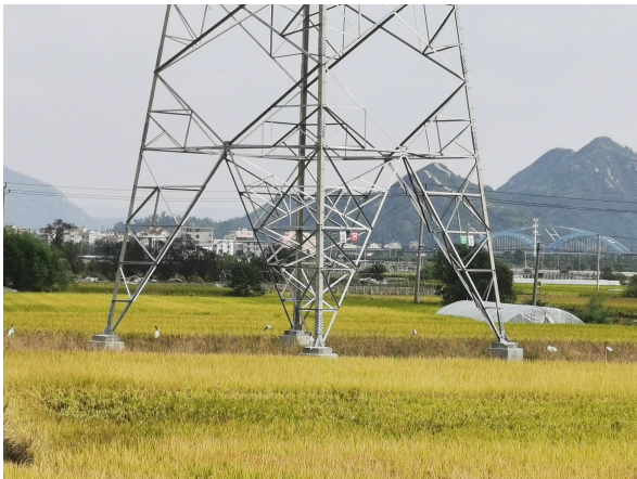
图 6-12 塔基下方植被恢复
