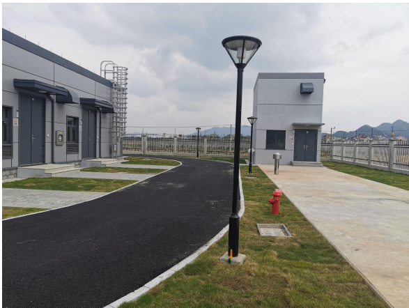
图 6-8 变电站内道路及绿化
