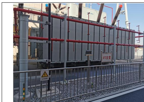
图 6-1 1#主变及主变下方油坑
