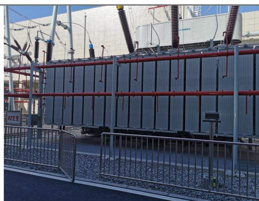
图 6-2 2#主变及主变下方油坑
