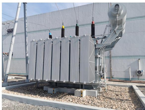
图 6-3 3#主变及主变下方油坑（本期）
