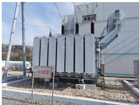
图 6-1 1#主变及主变下方油坑（前期）
