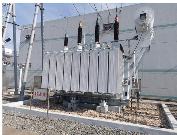
图 6-2 2#主变及主变下方油坑（前期）
