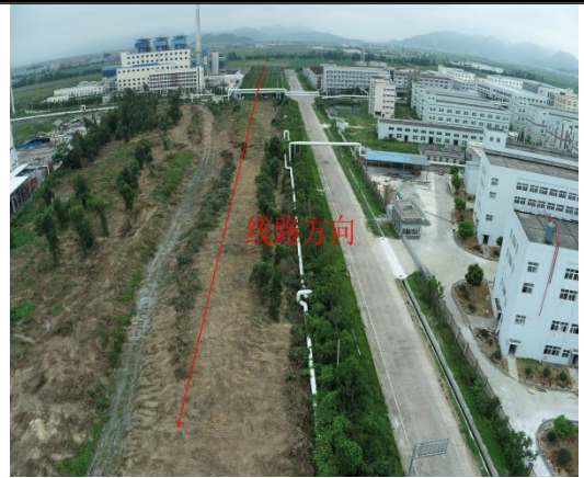
临港热电厂门口绿化带
