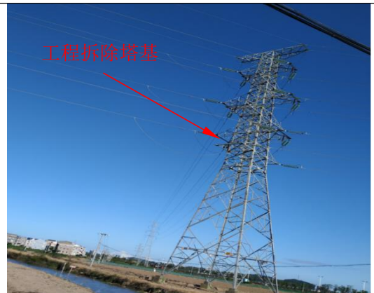
拟建工程拆除基塔现状
