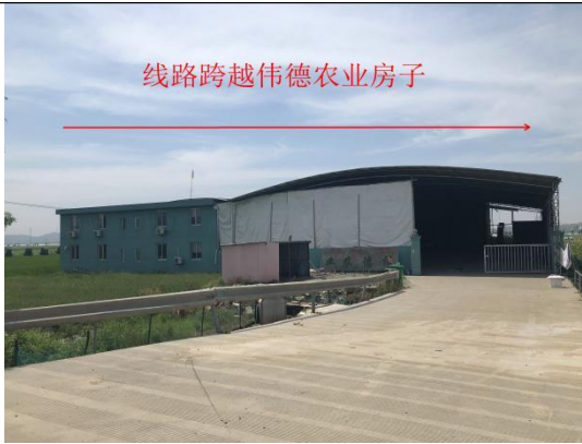
拟建线路跨越德伟农业厂房
