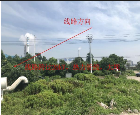
拟建线路跨越现状 20kV 高压线、大坝
