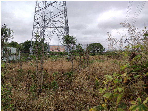
图 6-9 达门雁线塔基周边环境状况
