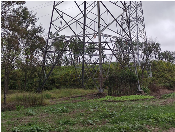
图 6-10 浦山、浦龙线塔基周边环境状况
