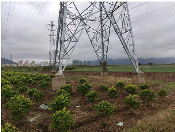
图 6-11 浦蓬、浦达线塔基周边环境状况
