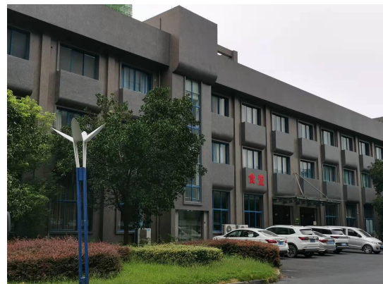
北侧-园区食堂
