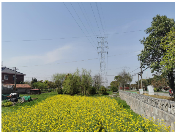
图 6-10 架空线路周边环境现状
