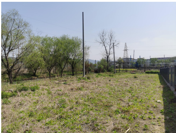
图 6-9 变电站周边环境现状
