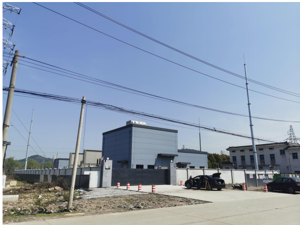
图 6-12 变电站全景及周边环境现状
