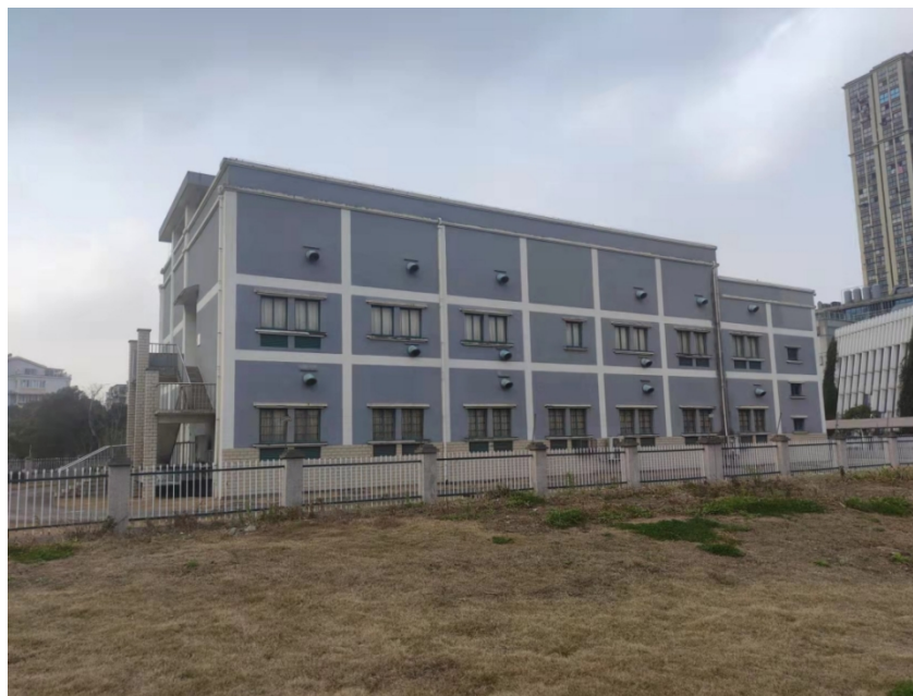
图 3-1 110kV 烟墩变电站现状图
