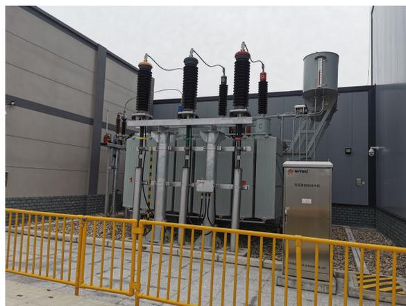
图 6-1 1 主变及下方油坑
