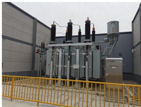
图 6-2 2 主变及下方油坑
