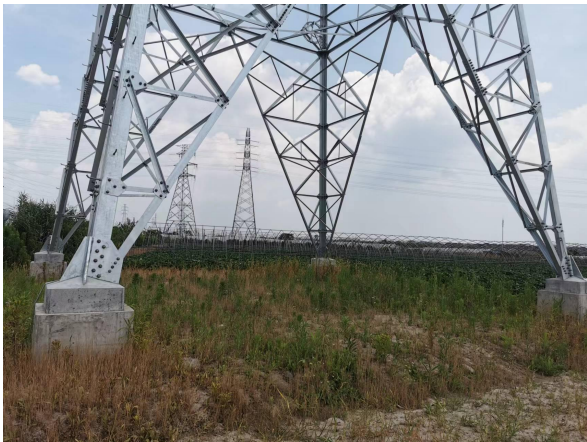
图 6-12 塔基下方植被恢复现状
