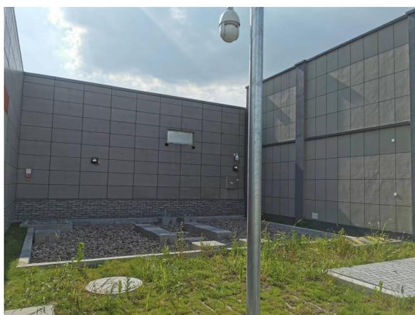
图 6-3 3#主变预留位置及下方油坑
