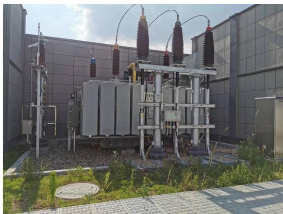
图 6-2 1#主变及下方油坑
