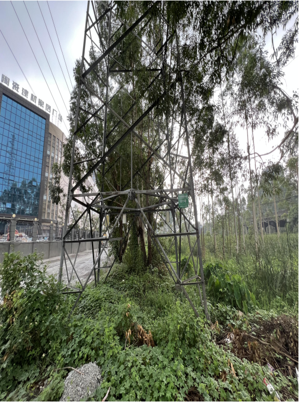
图 6-4 塔基周边植被恢复现状
