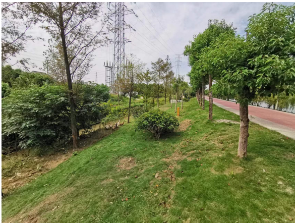
图 6-11 架空及电缆线路周边生态环境现状
