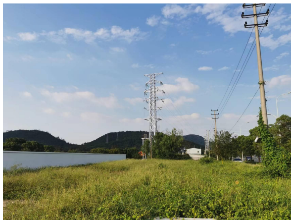
图 6-2 架空线路周边环境现状
