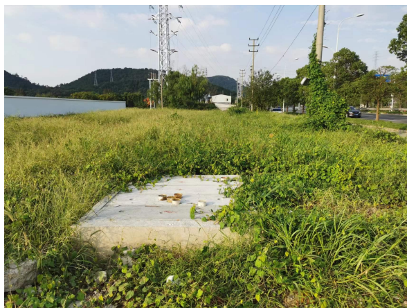
图 6-3 电缆线路周边环境现状
