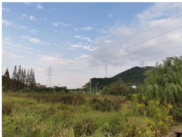
图 6-1 架空线路周边环境现状
