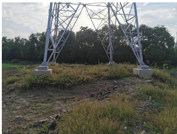
图 6-6 塔基周边植被恢复现状
