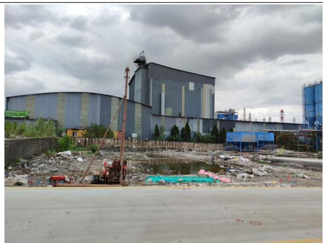
变电站东北侧
