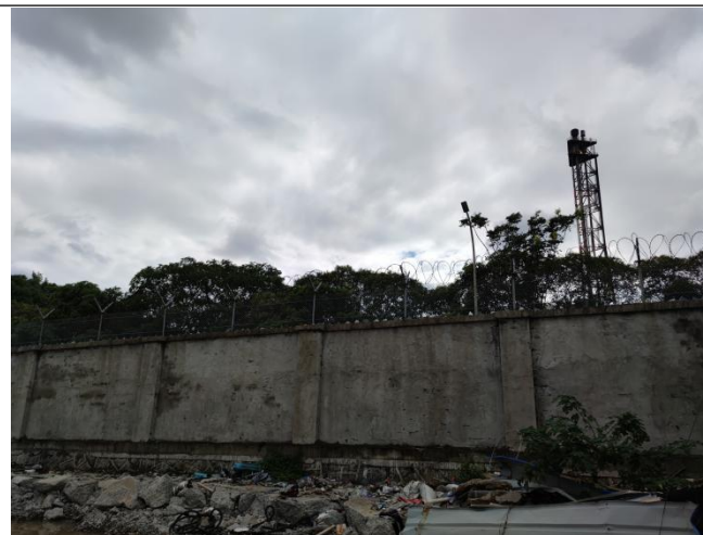
变电站西北侧
