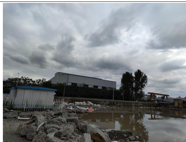
变电站东南侧
