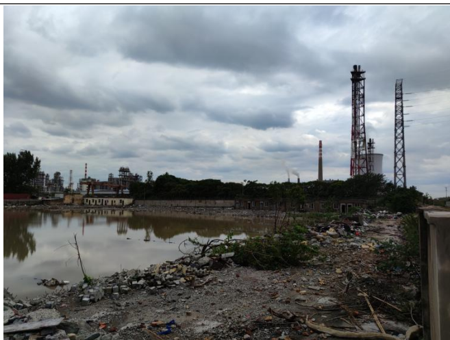
变电站西南侧
